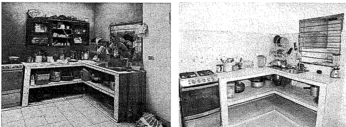
FOTO 4. ANTES Y DESPUES MEJORAMIENTO DE ZONAS HÚMEDAS
